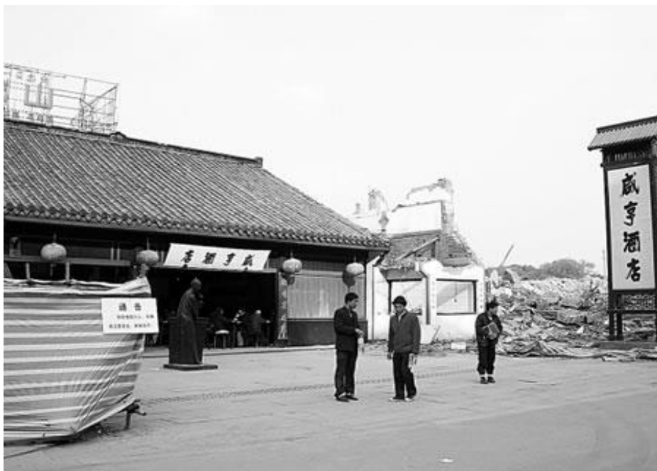
图 3-4 施工中的咸亨酒店
